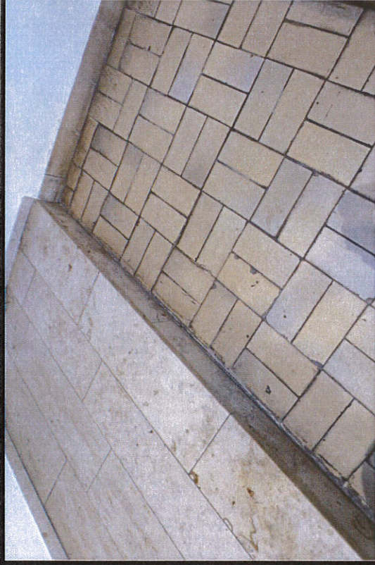
Bauzeitliche Fußbodenbeläge. (LWL-DLBW)
