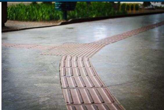
Beispiel für eine Rippenplatte
