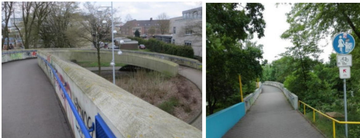
Abbildung 34: Zugang West (links) und Ost (rechts) Brücke L 587
