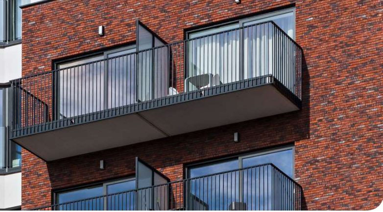
Abb. 30.1 Beispiel Balkongeländer aus pulverbeschichtetem Stahl
