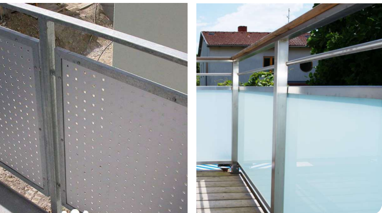
Abb. 30.2 Beispiel Ausfachung mit Lochblech und satiniertem Glas
