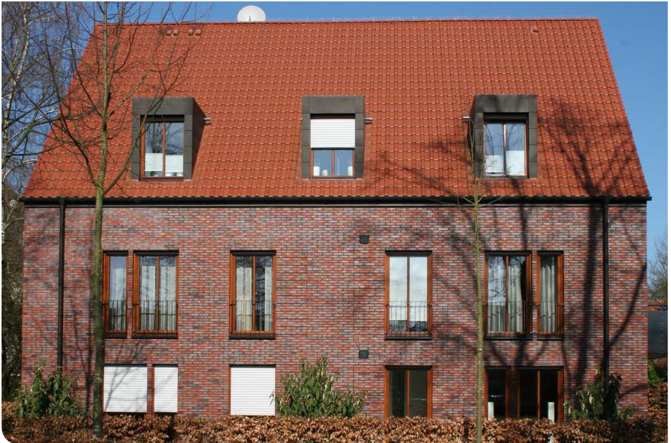
Abb. 28.1 Beispiel Anordnung Dachgauben
